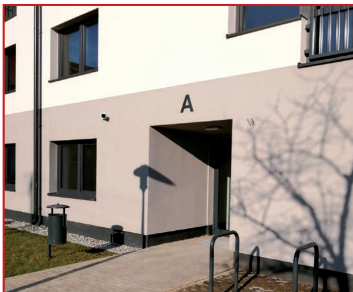
Wejście do budynku A. Fot. arch. UGR
